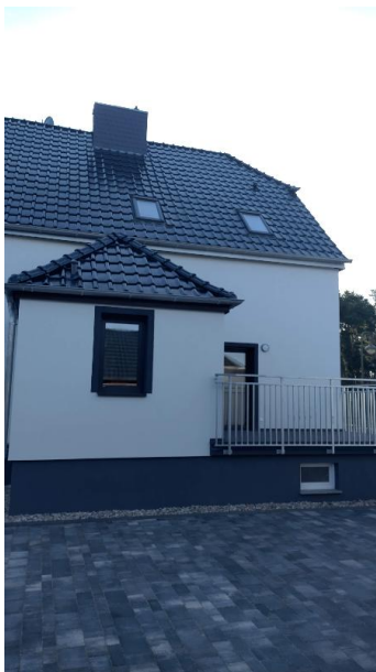
Ansicht Wohnhaus vom Hof
